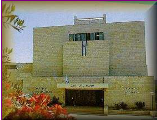
Façade de la Yéchiva
