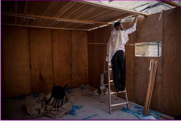
La construction de la Souca débute dès la fin de Kipour.
