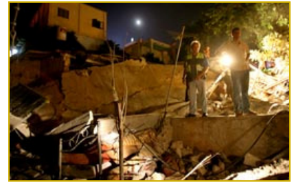
Immeuble détruit à Haïfa par une frappe directe d'une roquette lancée depuis Tyr, qui a fait trois morts, le 7 août 2006
